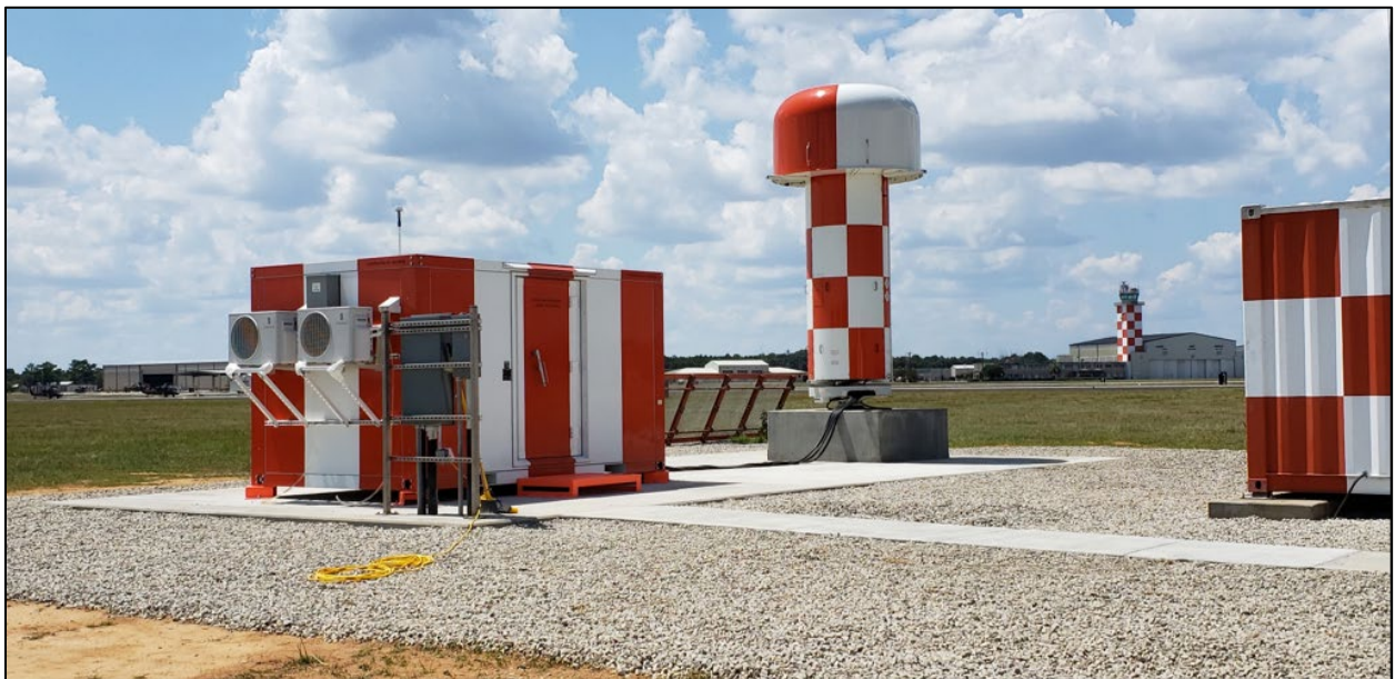
Figure 4-6 Typical PAR-2000/AN/FPN-68 PAR
