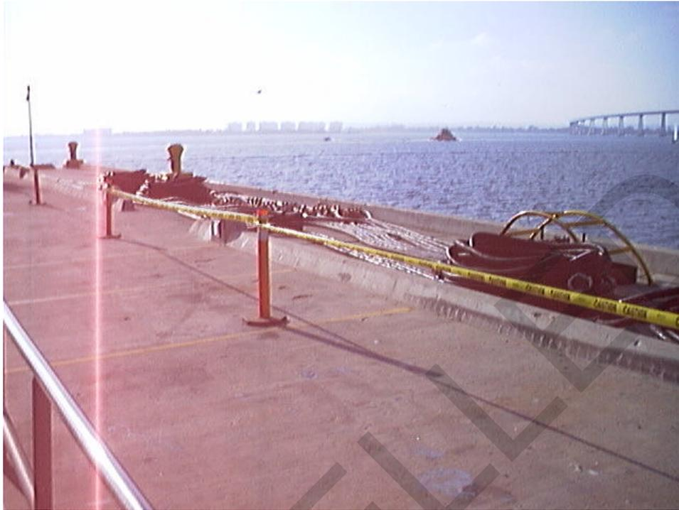
Picture L. **Cable protection safety barricades.**
