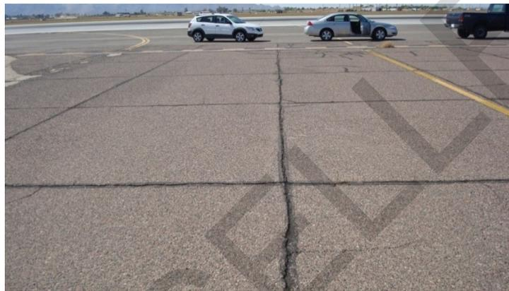
**Figure 9-3 Longitudinal Cracking**
